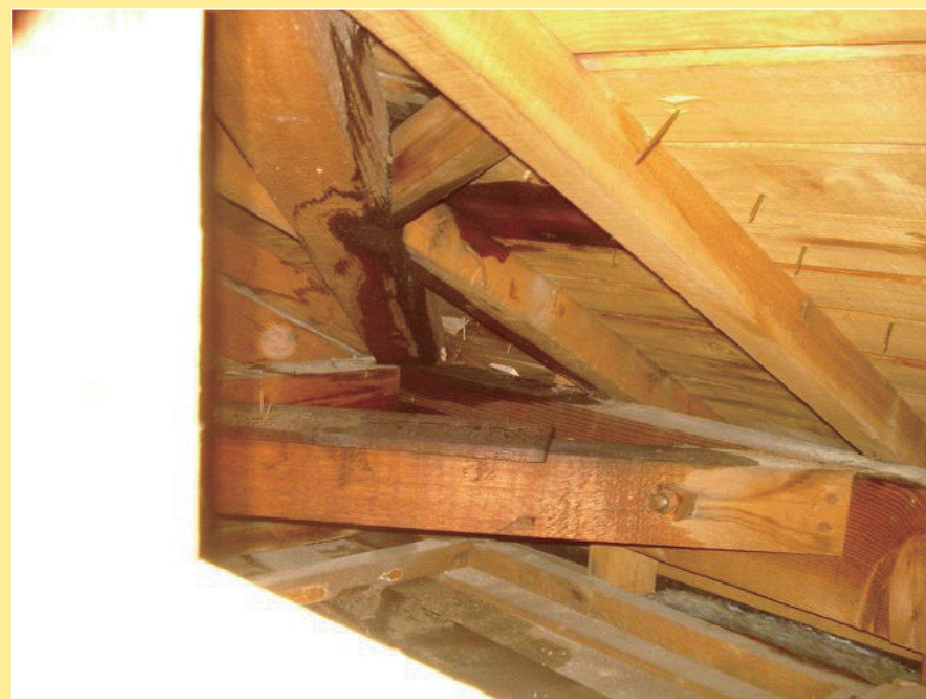
雨漏れなどの発見調査
