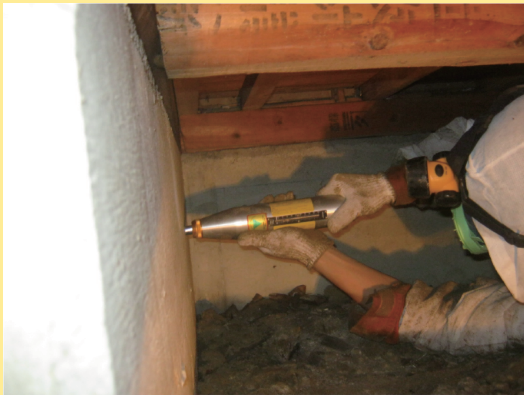
基礎の強度確認や、ひび割れ確認
