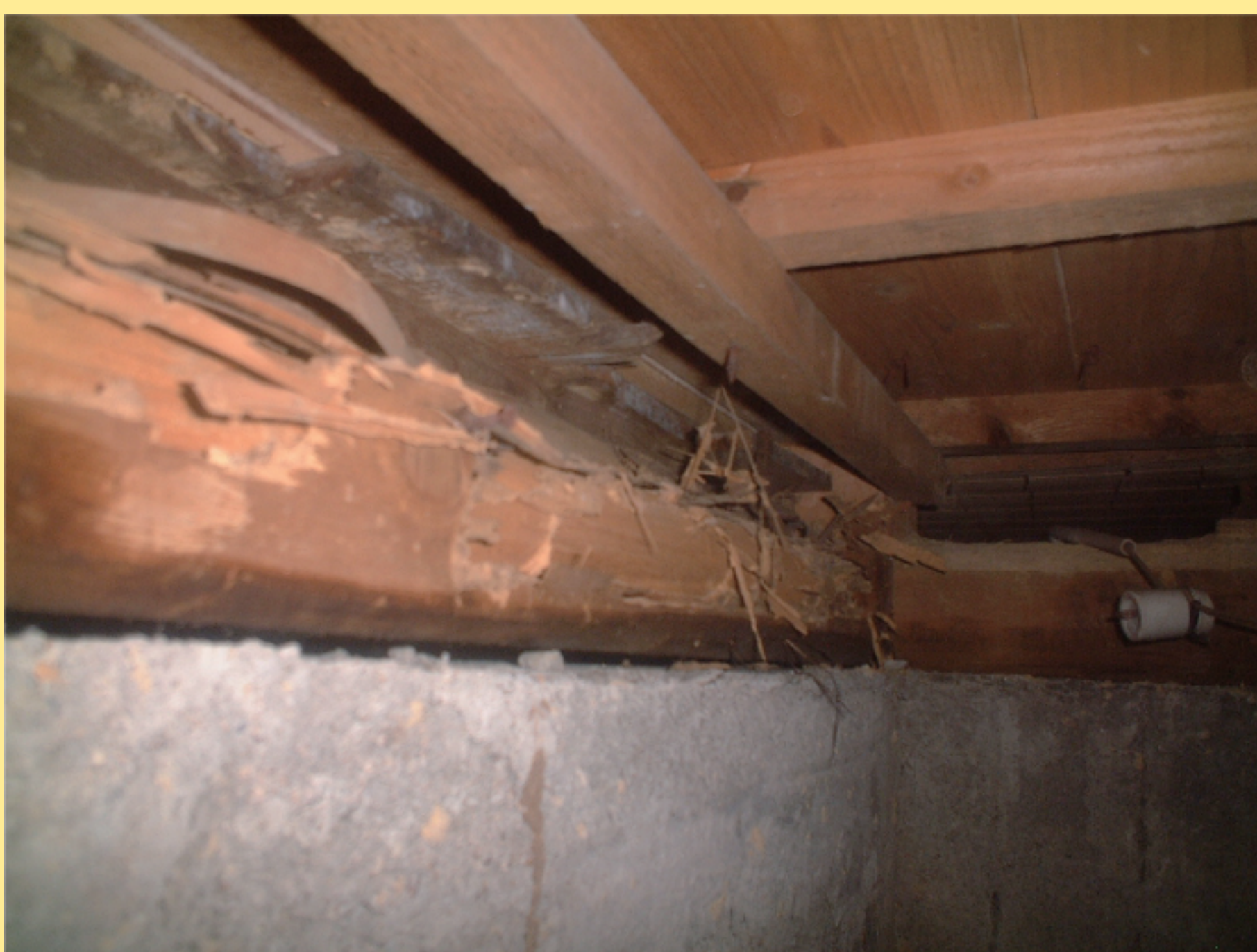
床下白蟻などの被害確認調査
