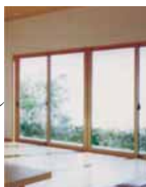
設置前の開口部
