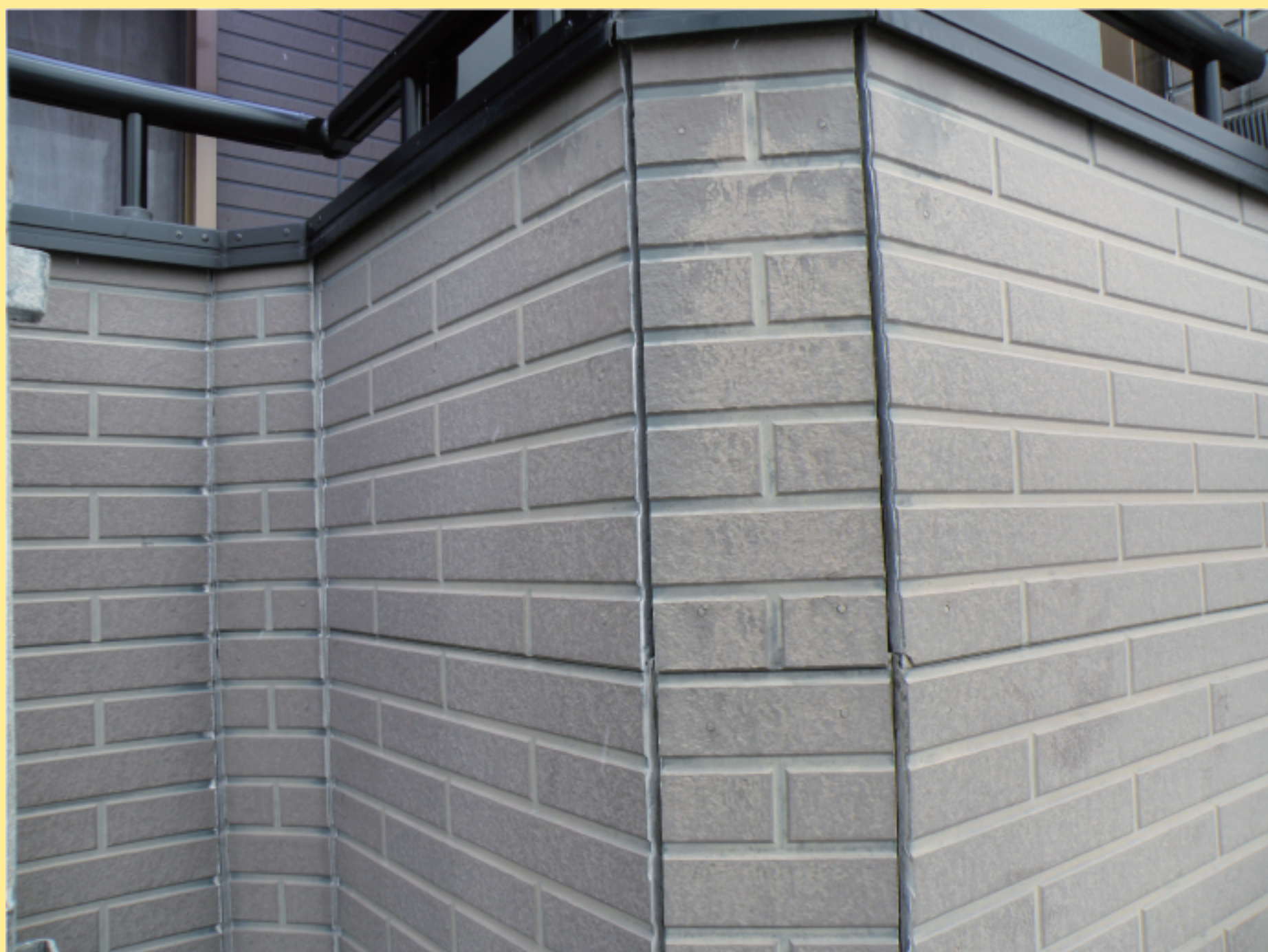
つなぎ目（ジョイントの劣化）確認
