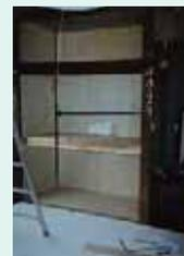
押入れや室内側から筋かいや構造用合板により補強(内装仕上げ工事を含む)
